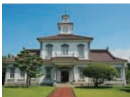
明治14 (1881) 年建築の旧西田川郡役所。重要文化財
