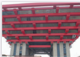
建設が進む中国館
