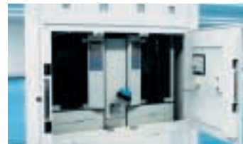
機内持ち込み制限品搬送のエアシューター
