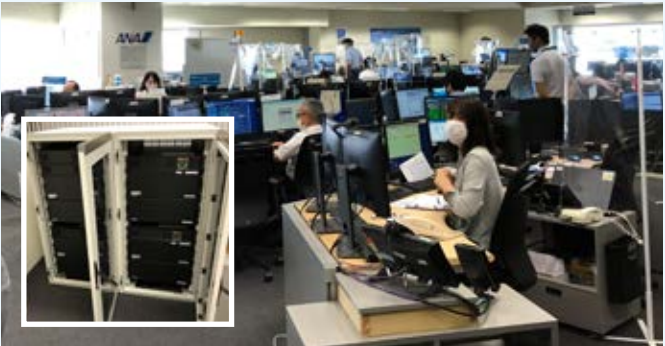
オペレーションマネジメントセンターと設置済みの大型蓄電池(左下)
