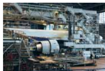
定時整備中はドックと呼ばれる足場が航空機を覆う。
